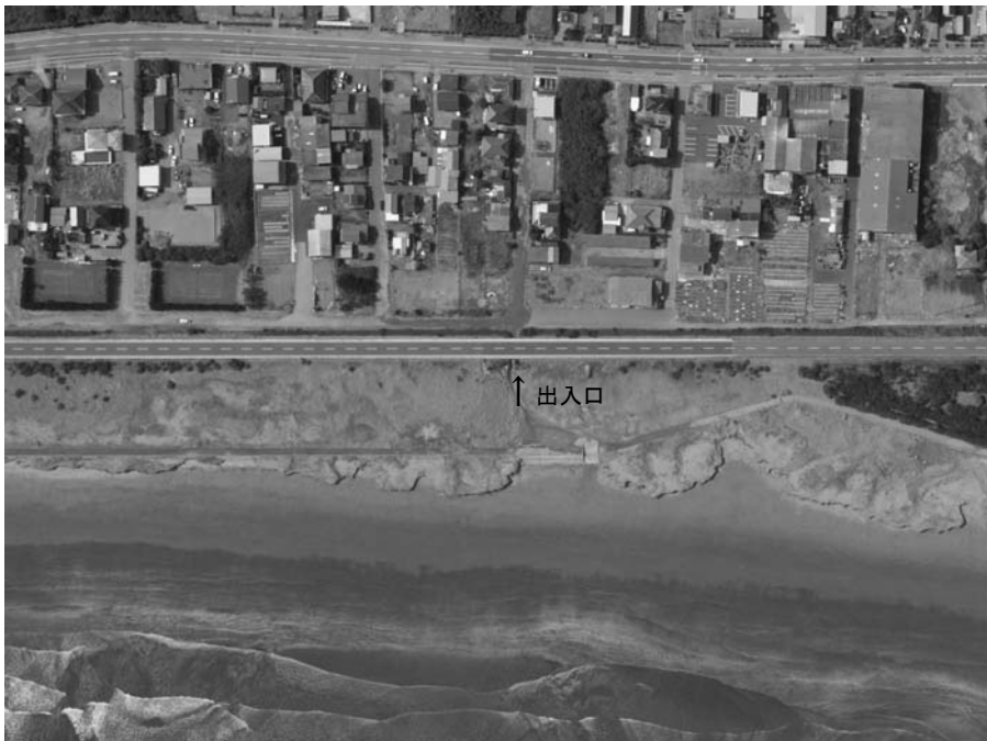
図2 九十九里町栗生～屋形周辺の津波後の海岸。波乗道路の下の出入口からは県道30号まで津波堆積物が分布する。京葉測量（株）により3月12日撮影
